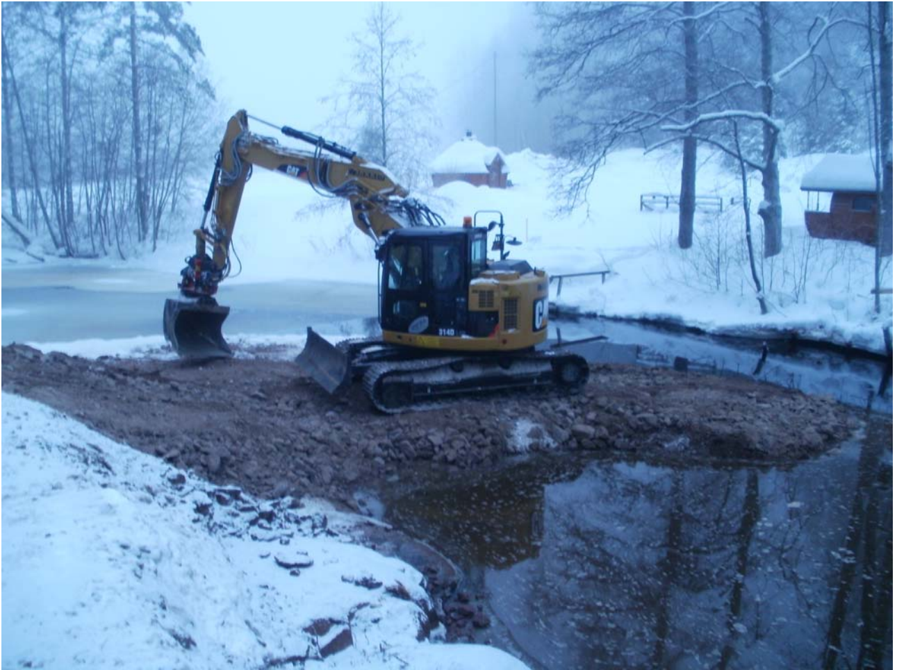
Kuva 6. Turpaankosken pohjapadon rakentamistyömaa 18.1.2011, jolloin vesistövaikutukset olivat suurimmillaan.
