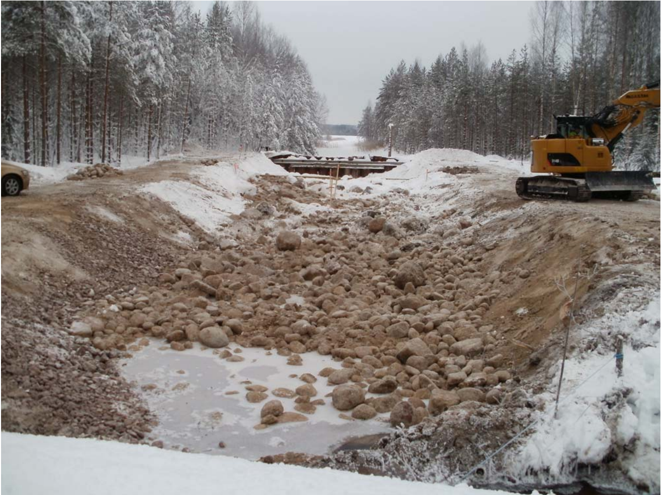
Kuva 4. Saaramaanjärven pohjapadon rakentamistyömaa 16.12.2010
